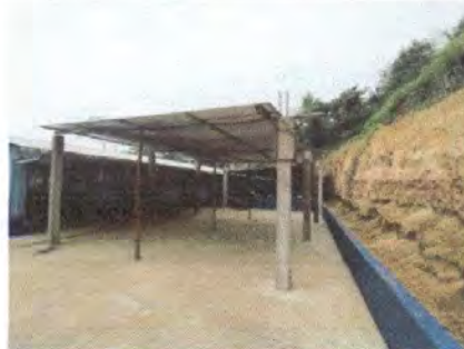
FOTO 3: Sustitución de capote de lámina para lámina troquelada
