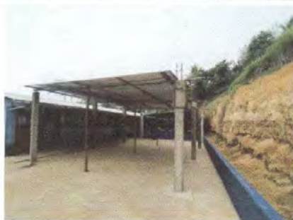
Sustitución de canal de metal
