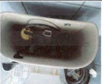
FOTO 9: Sustrucción de accesorios inodoro (contra llave, tubo de abasto y tanque)
