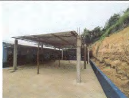
FOTO 3: Sustitución de capote de lámina para troquelada
