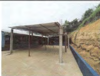
FOTO 5: Sustitución de canal de metal
