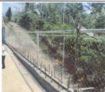
FOTO 6: Reparación de tubo hg y malla galvanizada
