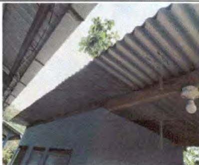
FOTO 7: Sustrucción de lámina, por lámina troquelada aluzinc calibre 26
