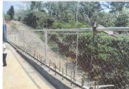
FOTO 5: Reparación de tubo hg y malla galvanizada
