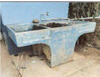
FOTO 11: Sustrucción de pila de cemento de un lavadero
