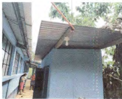
FOTO 8: Sustrucción de estructura de soporte de madera, por metal
