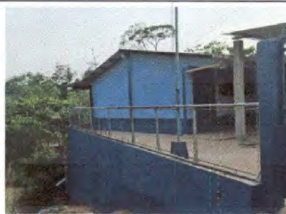
FOTO 12: Pintura en muros exteriores e interiores
